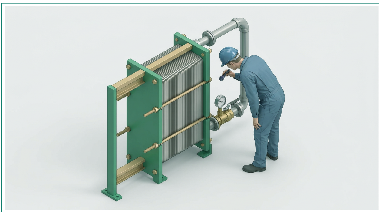
Проверка теплообменника и арматуры контура после скачка давления
